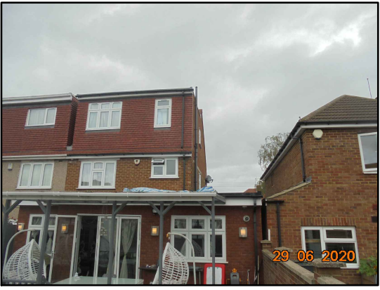
Existing Rear View of 64 & 66 Belmore Av
