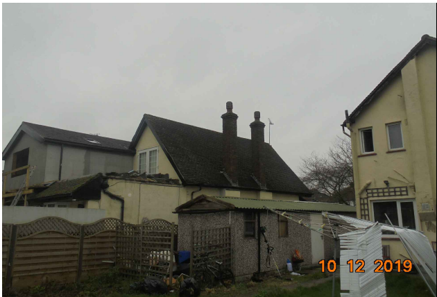
Existing Rear View of 19Lawn Av & 21 Lawn Av
