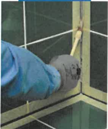
Application of Primer FD
