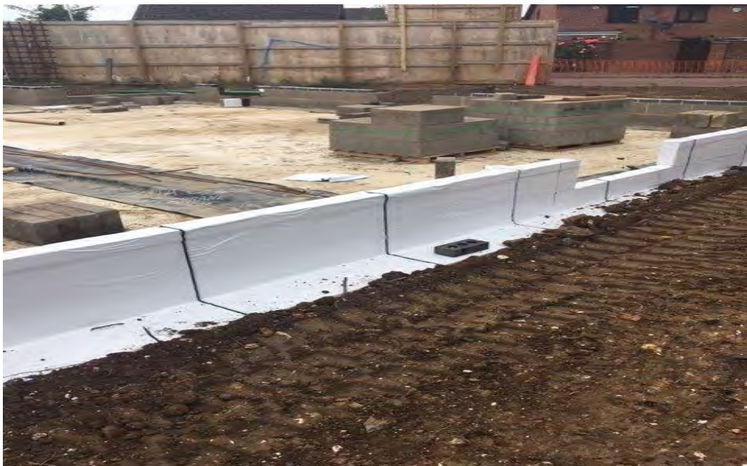
JUTA GP1 membrane with JUTA GRSAM door threshold detail
