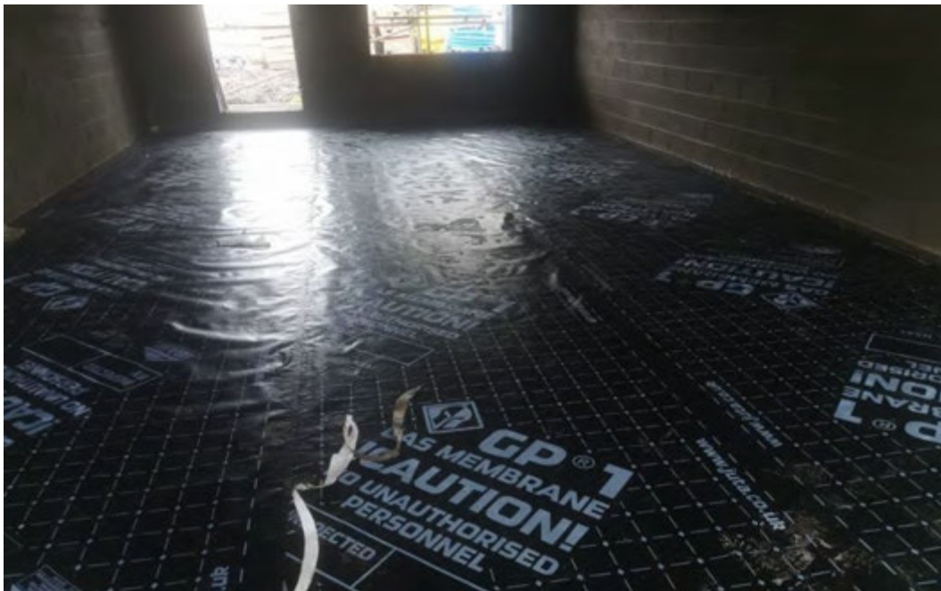
JUTA GP1 with JUTA GRSAM repairs
