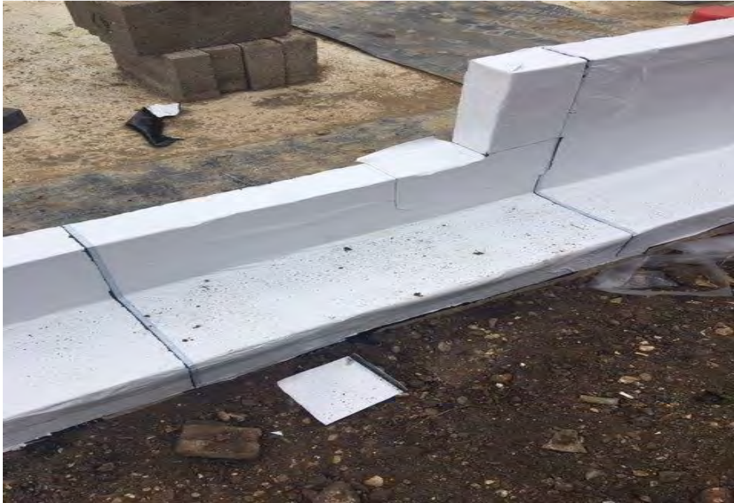
JUTA GP1 Gas membrane system with JUTA GRSAM
