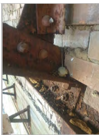
P18b: BOTTOM CONNECTION OF TRUSS E10
