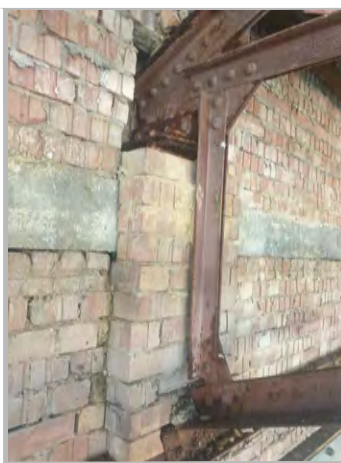
P18a: TRUSS E10
