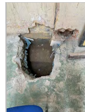
P20a: COLUMN N8
