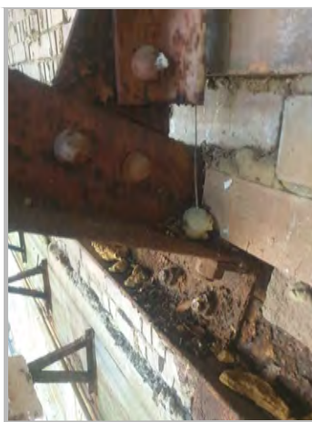
P18b: BOTTOM CONNECTION OF TRUSS E10
