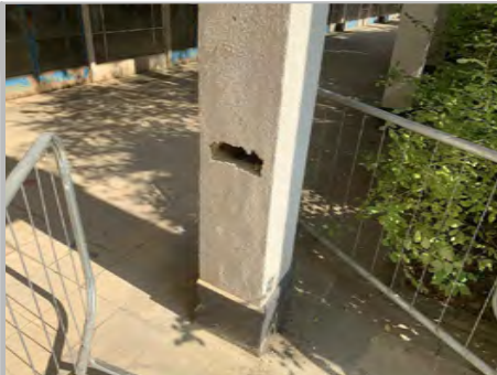
P12a: COLUMN E11
