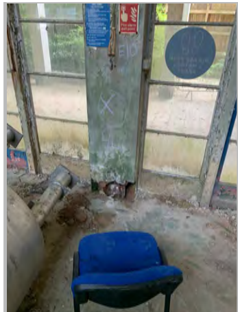
P11a: COLUMN E10
