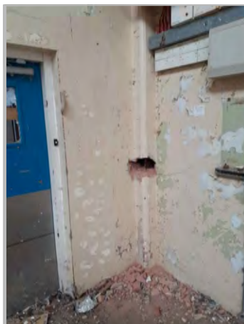
P6a: COLUMN C3
