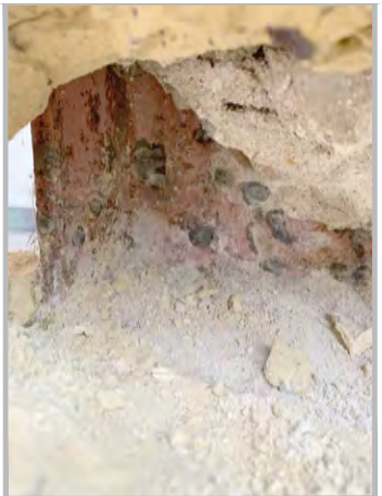
P25b: CLOSE UP VIEW OF COLUMN Q11
